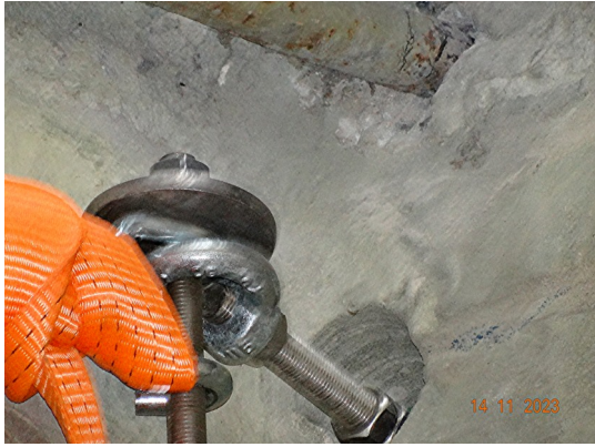
Verankerung der Notsicherung im Mauerwerk
