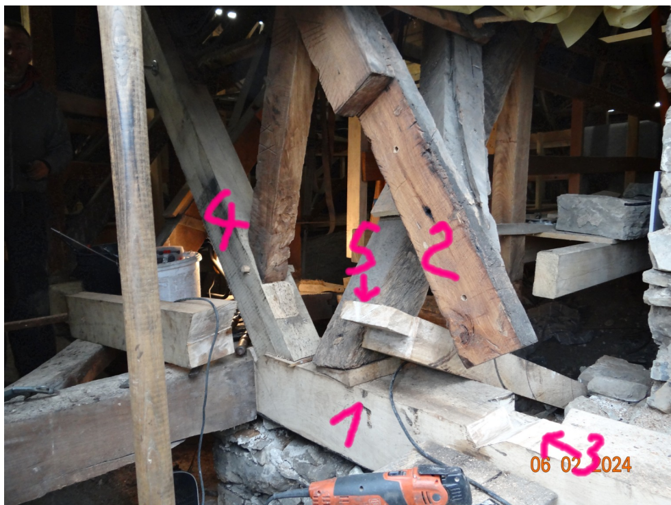
Aufliegerbalken (1) wurde ausgetauscht, da er total kaputt war. (2) ist das Dach der Apsis. (3) die Stirnseite des Balkens ragt aus dem Mauerwerk heraus und ist von außen sichtbar. (4) das Mauerwerk der Schildwand.
