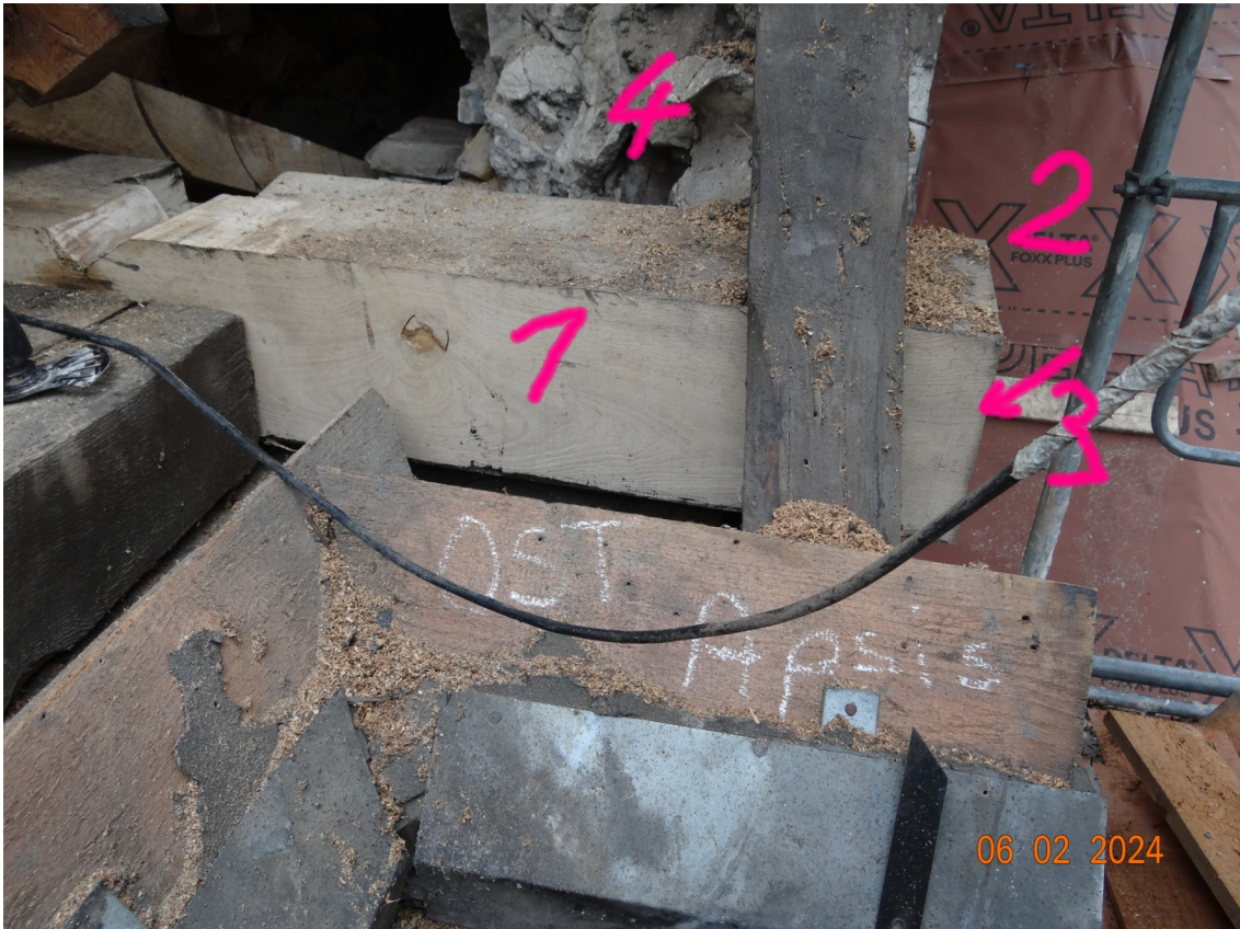
Aufliegerbalken (1) wurde ausgetauscht, da er total kaputt war. (2) ist das Dach der Apsis. (3) die Stirnseite des Balkens ragt aus dem Mauerwerk heraus und ist von außen sichtbar. (4) das Mauerwerk der Schildwand.
