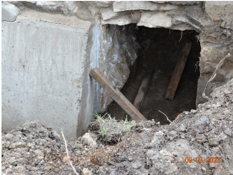
Hier sieht man ein von Hand ausgeschachtetes Loch unter dem alten Fundament und neben dem bereits fertigen neuen Betonblock.
