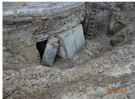
In der Mitte der Apsis sieht man zwei fertige Unterfangungen aus Quellbeton. Rechts und links daneben sind die fertig gestellten Löcher für die nächste Betonierung erkennbar.
