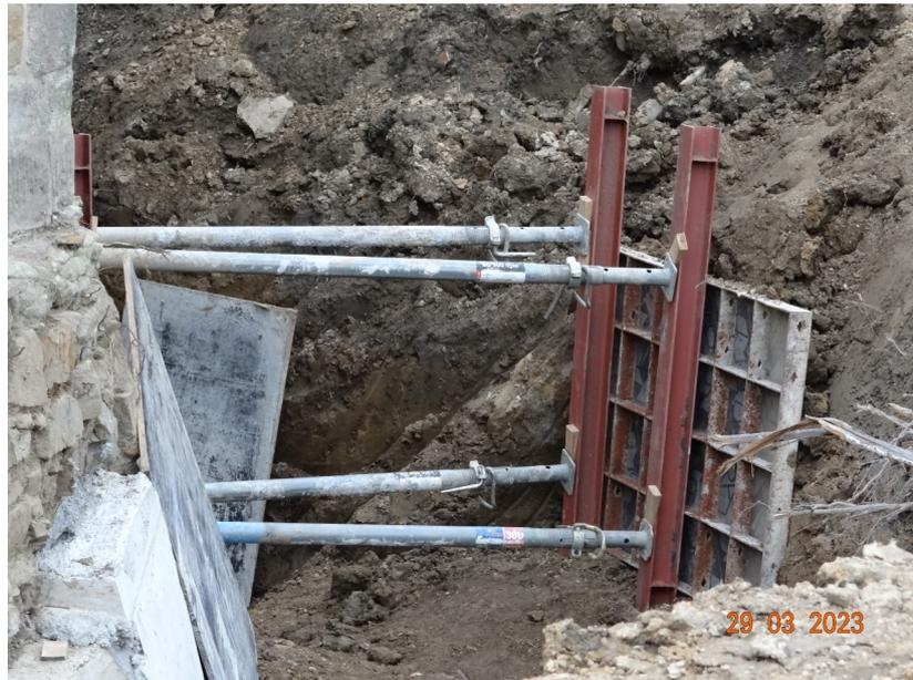
Die Baugrube wird mit stabilen Trägern gesichert.
