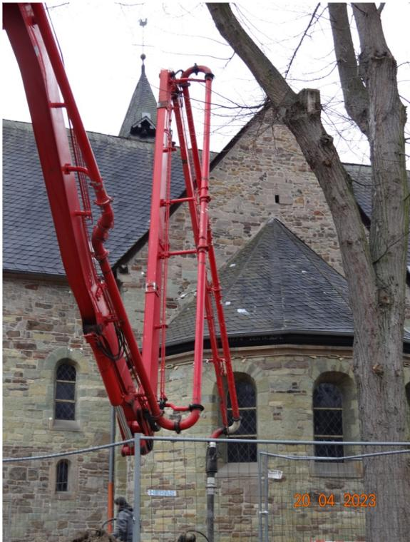
Es erfordert großes Feingefühl, diesen langen Pumpenarm an den Bäumen vorbei zur Einfüllstelle, Bild unten, zu dirigieren.
