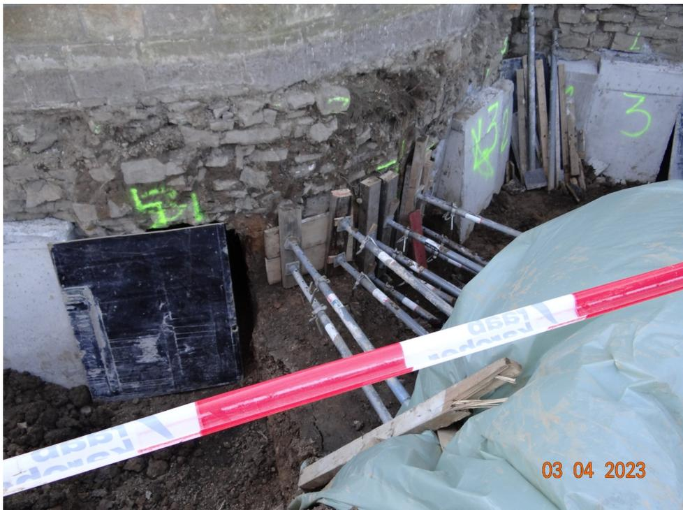
**04.04.:** Die Sicherungsarbeiten an der Baugrube werden fortgesetzt um das Mauerwerk zu schützen.
